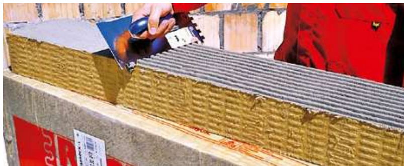
Obr. 5: Celoplošné nanášení lepicí hmoty
