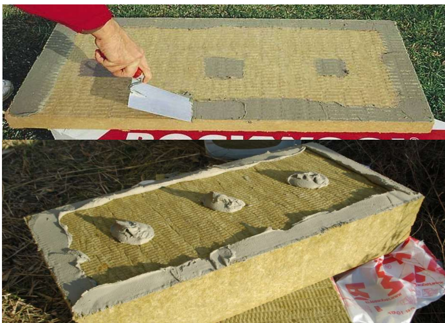
Obr. 4: Nanášení lepicí hmoty pomocí obvodového pásku
